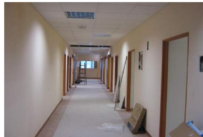
Część administracyjna w remoncie
